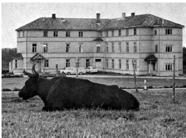
Bildet viser hovedbygningen på Hovelsåsen, etter at den i 1930 ble påbygd en etasje. Siden ble den pusset opp i flere omganger, før bygget brant ned i 1962. Husdyrhold var en del av den alminnelige gårdsdriften.
