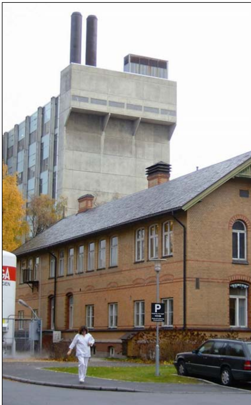
Gammelt og nytt – Ullevål sykehus i dag. I bakgrunnen ruvar Laboratoriebygget frå 1978. Arkitekt: Østbye Kleven Almaas. Bilde: Leif Maliks.
