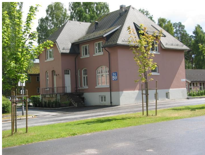
Fasade mot nord. Foto: Einar Ramsli.
