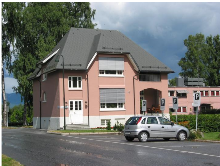
Fasade mot syd. Foto: Einar Ramsli.
